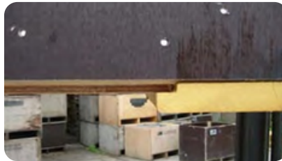
Es besteht ein Dickenunterschied zwischen der Sperrholz- und der Hartholz-Bodenplatte.
