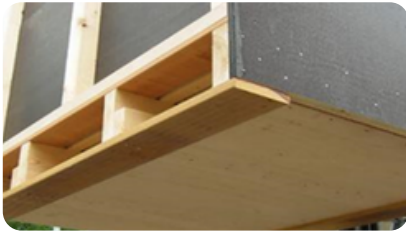
Der Palettenboden auf der Kiste ist mit 9 mm Sperrholz verschlossen.
